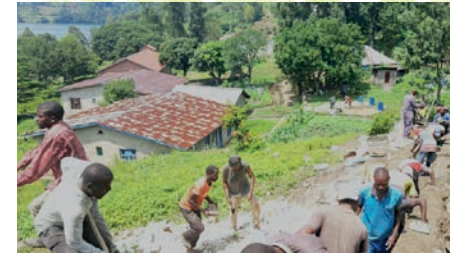
Er wordt gewerkt aan de afwatering
